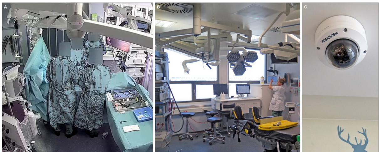
FIGUR 1 Operationsstue med Operating Room Black Box installeret. A. Oversigt fra optagelse fra operationsstuen og installation på selve stuen. B. Videodata fra stuen er blevet anonymiseret, samtidig med at stemmerne er blevet forvrænget. C. Mikrofoner og et vidvinkelkamera, der optager på stuen, er installeret i loftet.
