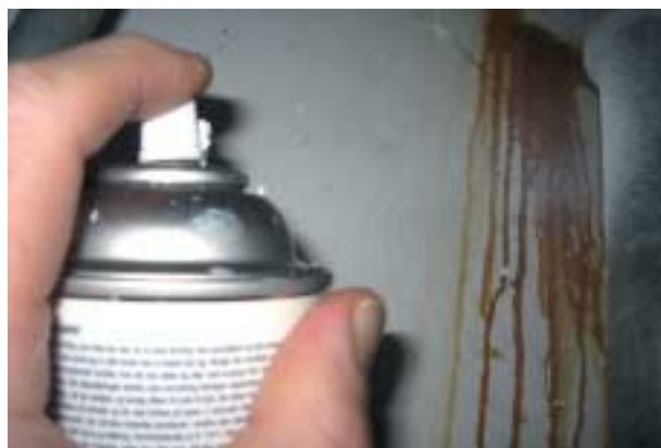
Figur 1. Aerosol til overfladebehandling af fugtskader efterlader en vandtæt belægning på væggen.
